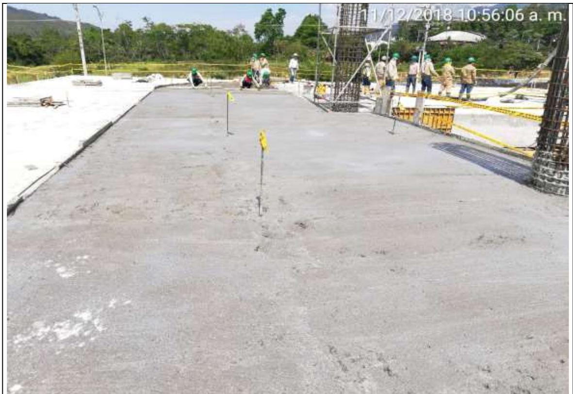
FUNDICION DE PLACA EN CONCRETO DE 4000 PSI EN ZONA DE TRANSFERENCIA
