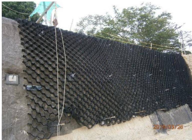
Instalación Geoceldas talud sur patio taller
