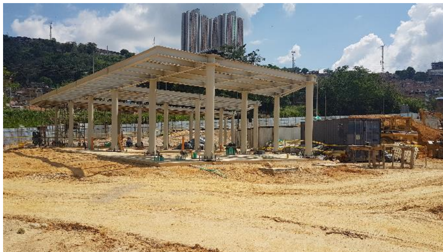
Construcción de estructura metálica oficinas patio taller
