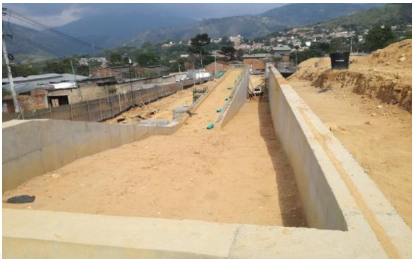
Construcción de rampas de acceso a zona de plataforma estación de transferencia de usuarios
