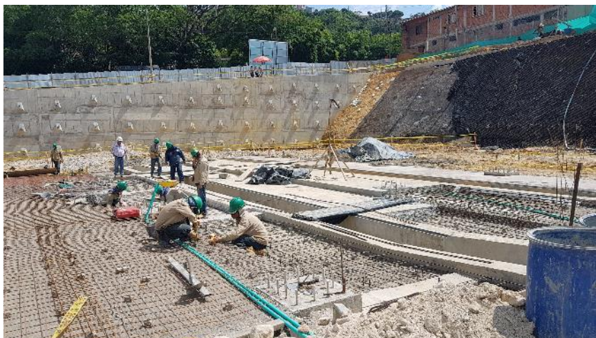
Construcción de cárcamos zona de mantenimiento
