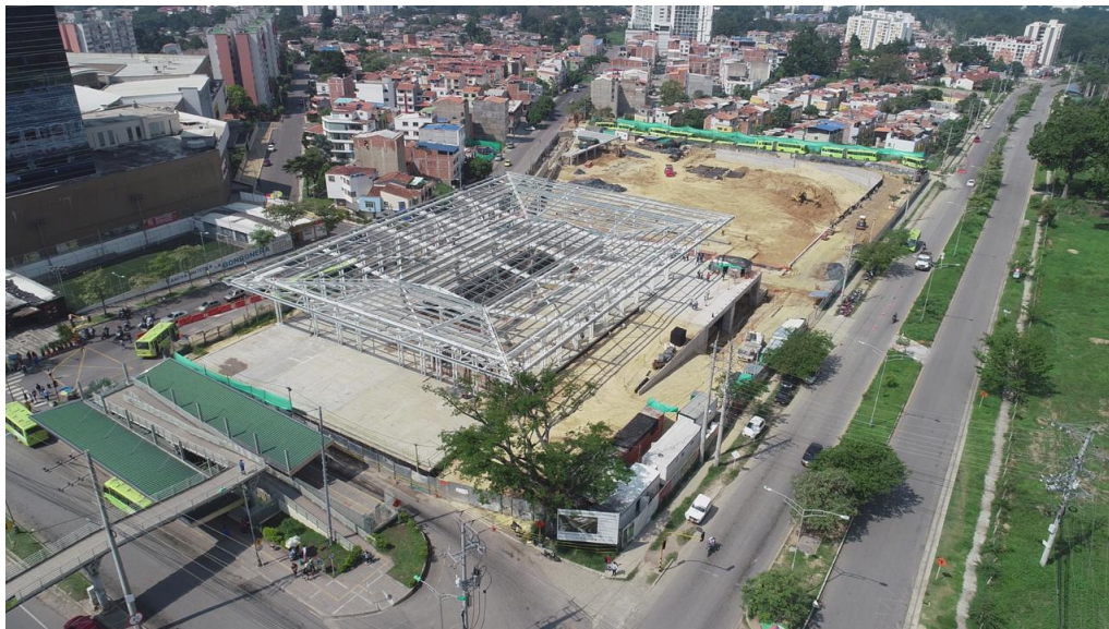
Vista aérea construcción Portal Piedecuesta
