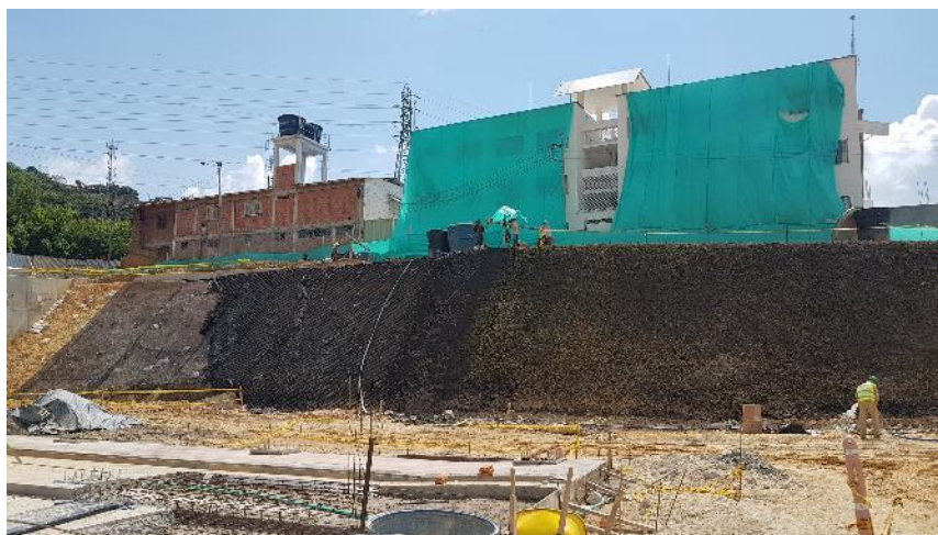
Construcción de talud con pantallas pasivas, geoceldas y material orgánico en talud occidental patio taller
