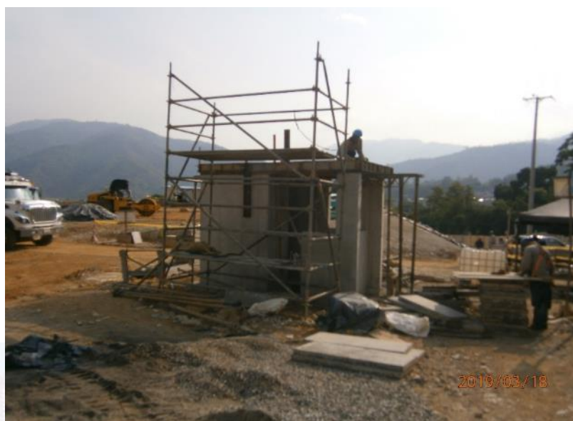
Construcción de Portería patio taller
