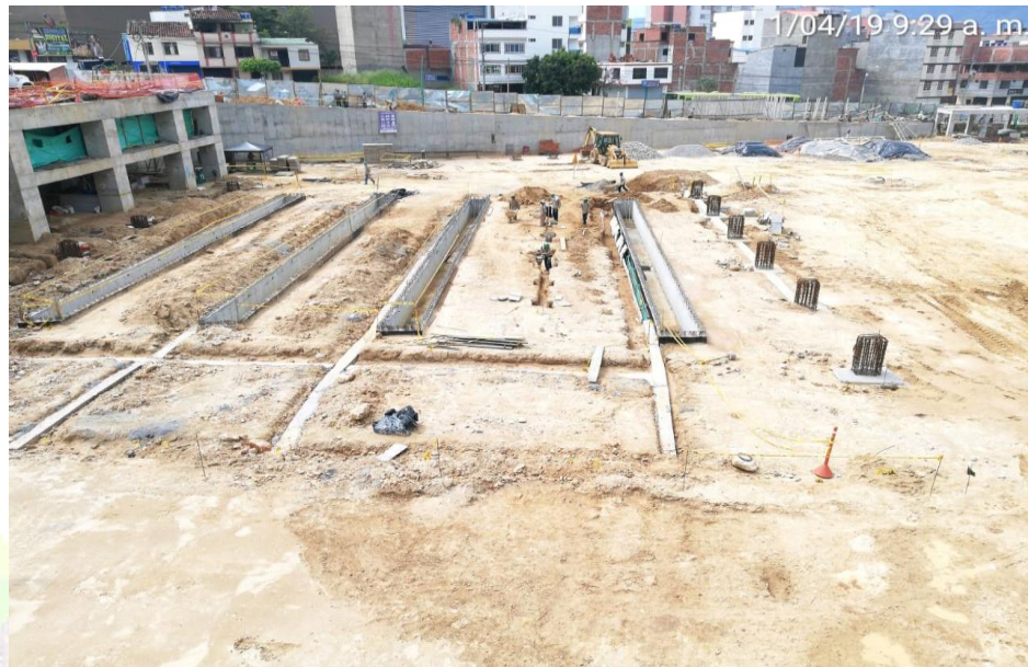
Construcción de cárcamos patio taller
