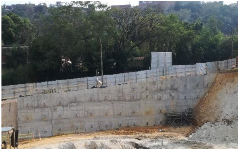
Construcción muro pantalla anclada sector sur Patio taller
