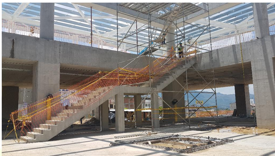
Construcción de escaleras internas zona de transferencia
