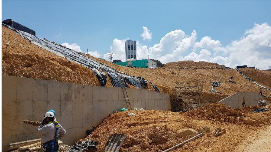
Construcción de muro de estabilización con micropilotes en talud medio
